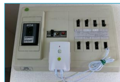
(取付け完了例)
